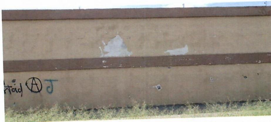
Como se puede observar en las imágenes el muro se encuentra en muy malas condiciones por la humedad que posee, de igual forma este muro se debe pintar e impermeabilizar por ambas caras. Se debe rellenar con concreto todas las grietas existentes u huecos antes de dar el acabado final al muro.
