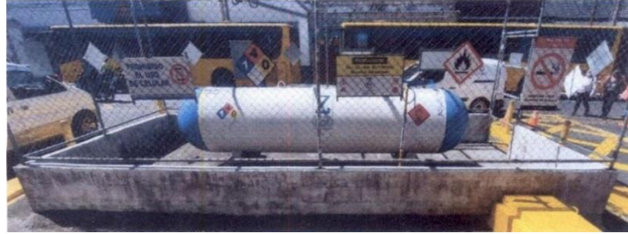
Imagen 2. Muro perimetral en concreto. (Fotografía tomada del informe técnico)
