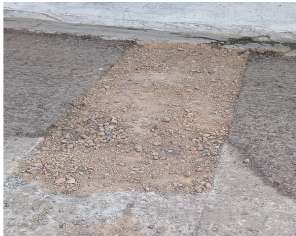
Imagen 3. Área donde realizaron excavaciones.
