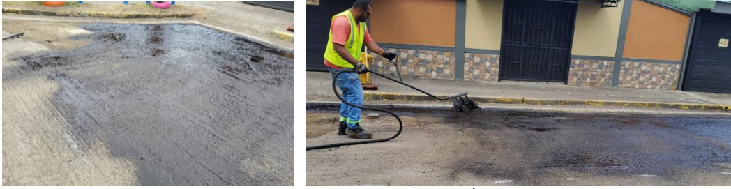
Imagen 7. Zonas con exceso liga, aplicación manual.
