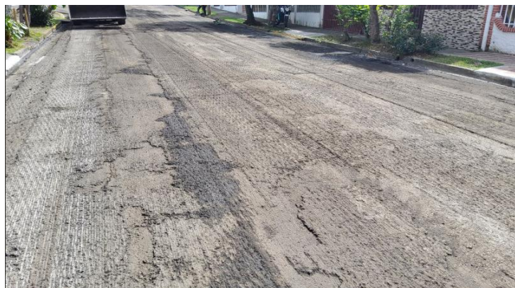
Imagen 1. Calle a la cual se le removió la carpeta existente (Av.16 Cementerio)
