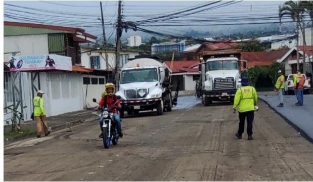
Imagen 13. Vía en proceso constructivo sin control vehicular.
