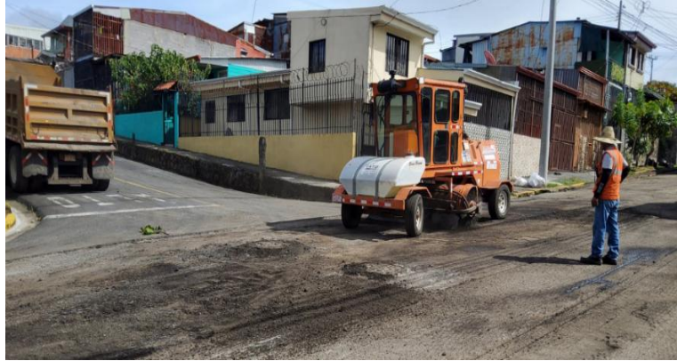
Imagen 4. Barrido del área perfilada con equipo mecánico.
