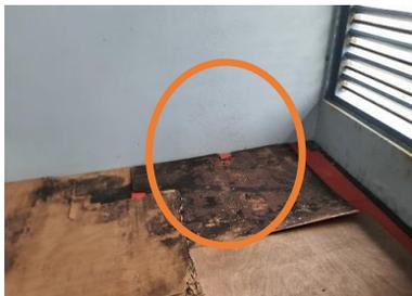
**Figura Nro. 3.1.2.a) Presencia de agua en la lámina protectora del piso**
