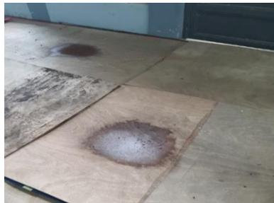
**Figura Nro. 3.1.2.a) Filtración de agua**
