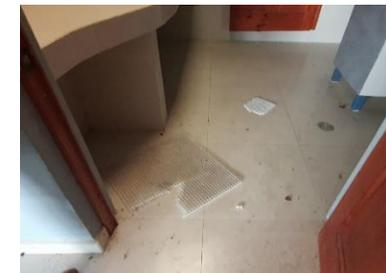
**Figura Nro. 3.1.2. a) Desprendimiento de lámina plástica del cielo raso**
