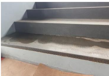
**Figura Nro. 3.1.2. a) Agua en la gradería**
