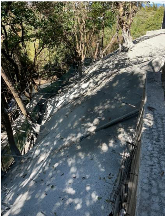
Muro urbanización La Cordillera
