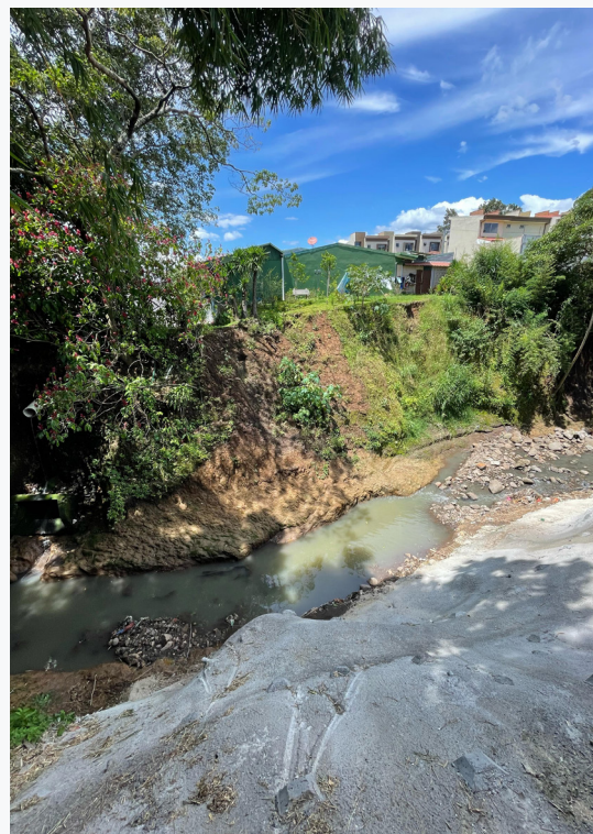
Muro urbanización Cubujuquí
