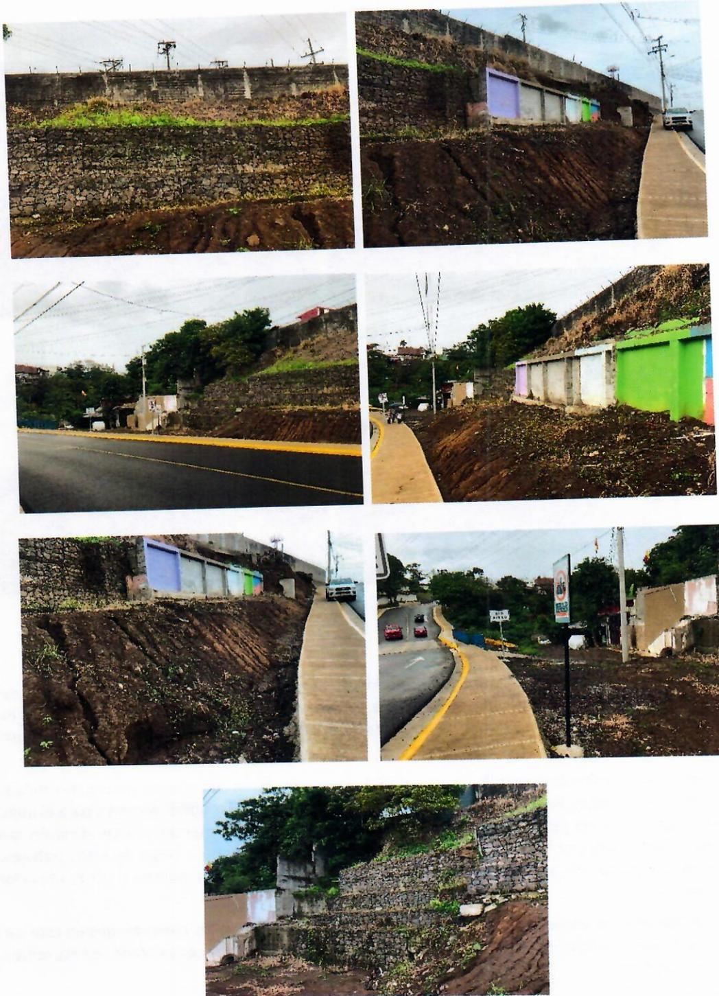
Condición actual de los taludes a estabilizar por control de erosión y prevención en cercanías de los bastiones del puente las cloacas y parque a remodelar:
