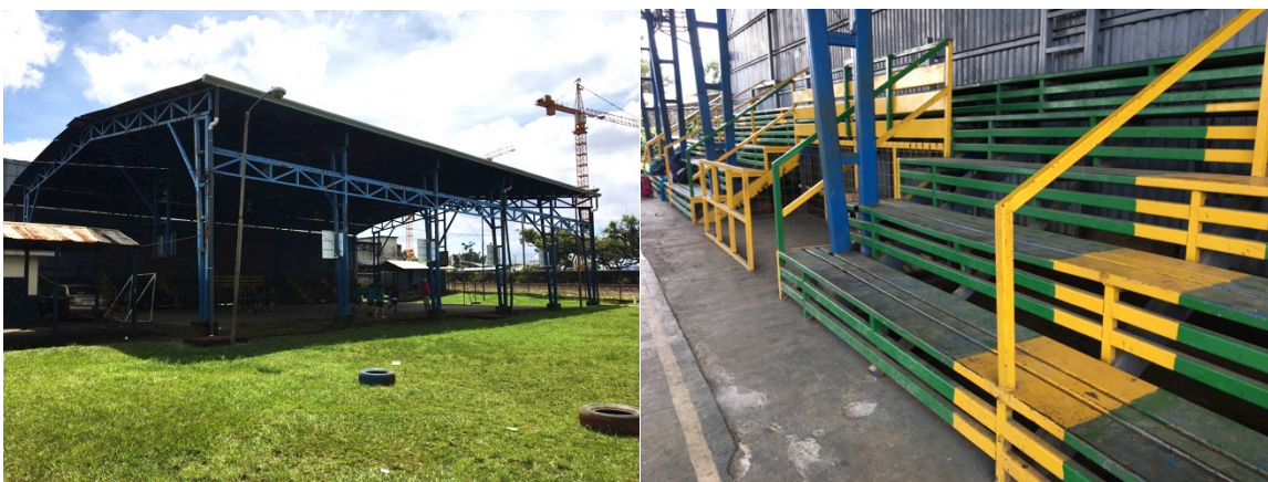
GIMNASIO ESCUELA SAN FRANCISCO ANTES
