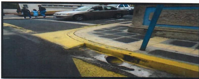
Para esta rampa tipo "D" se deberá verificar muy bien y previamente, el desfogue de aguas pluviales con la ubicación de tragantes o cajas de registro ya que es una masa de concreto encima del cordón de caño y no lleva tuberías por ser en una rampa en forma de toda la ochava.
