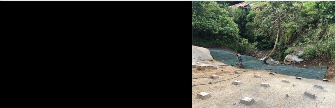
Es por esto por lo que se construyó un muro de estabilización tipo suelo cosido y se canalizaron las aguas pluviales. El área total intervenida fue de 330 m<sup>2</sup> de muro en suelo cocido y 108 m<sup>2</sup> de geomanta para control erosivo.
