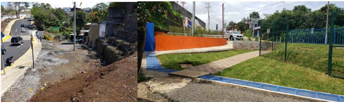
Las mejoras consistieron básicamente en la construcción de aceras peatonales, una rampa de acceso, construcción de una banca en concreto, muros de confinamiento para la creación de jardines, cerramientos para evitar que las personas se acerquen al margen del río y enzacatado.
